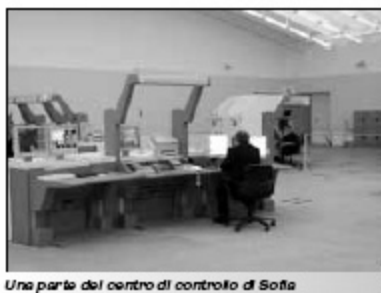
Una parte del centro di controllo di Sofia
